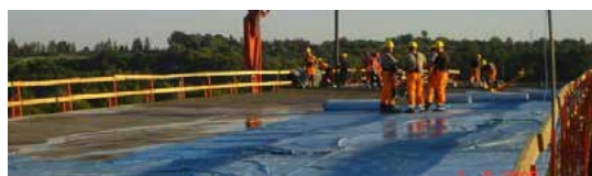
Zdjęcie 5. Zabezpieczenie betonu włókniną polewaną wodą
