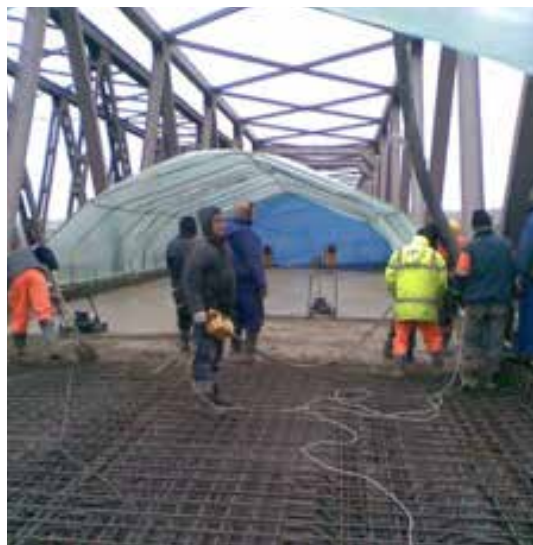
Zdjęcie 6. Wykonanie robót z zastosowaniem ciepłaka
