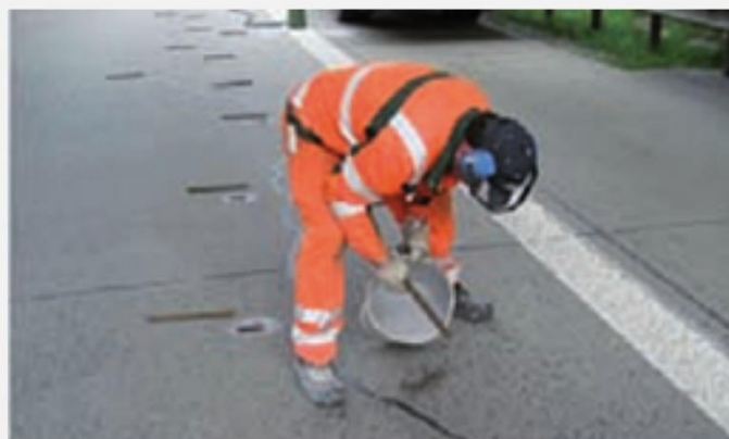
Klamrowanie rozdzielonych pęknięciem części płyty betonowej
