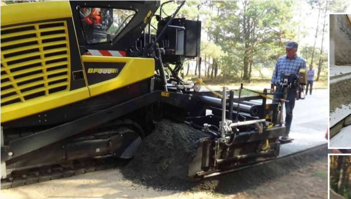
4. Układanie mieszanki betonowej
